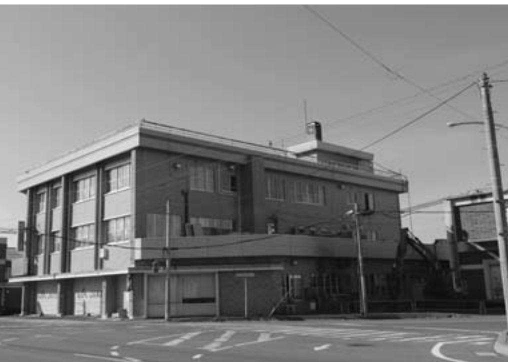
令和7年10月 解体作業の始まった旧農協会館
